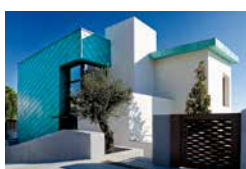
Privathaus, Sant Vincenç de Montalt, ES Marga Pérez Canal & Ana Aparicia, Barcelona KME Architectural Solutions, Sta. Perpètua de Mogoda, Barcelona TECU® Patina
