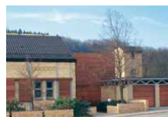
Privathaus, Nürnberg, D Haid+Partner Architekten+Ingenieure, Nürnberg Schlosserei Spenglerei Straßl, Arnstorf TECU® Classic_bond
