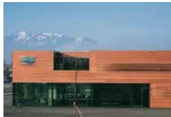
Büro- und Gewerbehaus, Koblach, A AIX Architects, Feldkirch Peter GesMBH + CoKG, Koblach TECU® Classic
