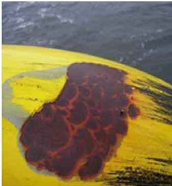
*La 3e couche de revêtement de la pièce de transition, débarcadère et tube en J endommagés en raison de l'amarrage des navires de service.*
