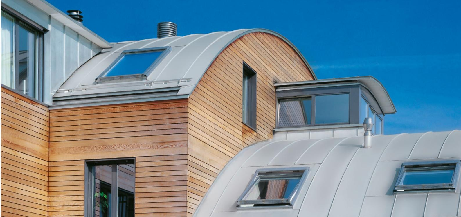
TECU® Zinn ist speziell oberflächenbehandeltes, beidseitig verzinntes Kupfer der Ausführung TECU® Classic. Die matte Oberfläche entwickelt sich durch freie Bewitterung im Lauf der Zeit weiter. So entsteht allmählich ein mattgrauer, warmer Farbton, der ausgezeichnet mit vielen anderen Baustoffen harmoniert.
